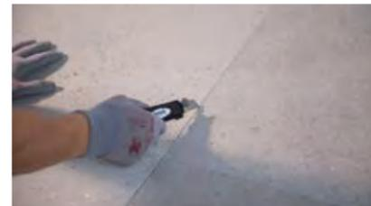
13- Antes de proceder al rejuntado, revisar que el material de agarre haya endurecido. Retirar los restos de cruce- tas, limpiar las juntas de colocación en toda su longitud, anchura y profundidad y finalmente, comprobar que no quede humedad en el interior de la junta.
