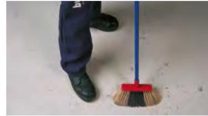
3- La superficie a revestir debe estar totalmente limpia de polvo o cualquier otra sustancia que pueda perjudicar la adhesión de las baldosas. Para colocaciones específicas (sistemas de calefacción radiante, fachadas con anclajes mecánicos, cerámica en techos ó resolución de parámetros particulares de proyecto) solicitar información concreta adicional para cada situación.
