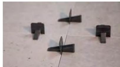
8- Las juntas de colocación serán de al menos 1 mm en colocaciones interiores y 5 mm en pavimentos exteriores. En colocaciones a junta trabada, realizar la colocación a 3/4 de pieza. Se recomienda el uso de crucetas autonivelantes.
