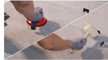
12- Tanto durante la fase de colocación como antes de finalizar la jornada, revisar la calidad del trabajo realizado antes de que el material de agarre complete su tiempo de ajuste y corregir los defectos mediante el uso de ventosas y mazas de goma.
