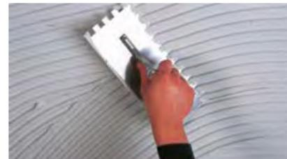
6- El único sistema de colocación recomendado es la colocación en capa fina y llana dentada. En baldosas con formato superior a 1.000 cm<sup>2</sup> (33x33 cm), se recomienda la técnica de doble encolado, con aplicación del adhesivo tanto sobre el soporte como en el dorso de la baldosa cerámica.
