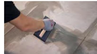
15- Respetar las recomendaciones del fabricante en la preparación y utilización de los materiales de junta. Comprobar que el material y herramienta elegida no dañan la superficie de la cerámica. El material de rejuntado se aplicará con llana de goma. En los catálogos de **VENIS** encontrará el material de butech recomendado para cada modelo.
