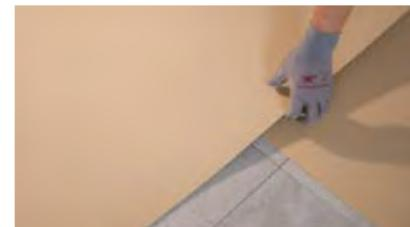
17- Proteger el pavimento contra cargas prematuras, otros trabajos de obra y condiciones climáticas adversas. Se recomienda cubrir los pavimentos con láminas o paneles que eviten la acumulación de suciedad y protejan del rayado, la abrasión y golpes.
