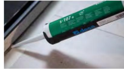
10- Las juntas perimetrales estarán presentes en esquinas, cambios de plano del pavimento y cambios de material. Se recomienda cubrir con el zócalo o la propia baldosa y sellar con una masilla elástica. Anchura mínima de la junta: 8 mm.
