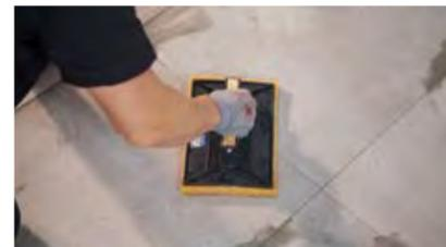
16- Esperar a que el material de juntas empiece a secar y limpiar con una esponja humedecida en agua limpia. No dejar que el material de juntas endurezca sobre la cerámica, sobre todo en baldosas con relieve. No empapar la junta con exceso de agua.
