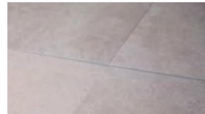
14- El relleno de juntas se debe realizar cuando las baldosas se encuentren perfectamente adheridas al soporte. En el caso del pavimento, se deben respetar las recomendaciones del fabricante de adhesivos, con el fin de dejar transcurrir el tiempo suficiente antes de ser pisado o sometido a cualquier tipo de carga. Se pueden evitar así despegues o roturas prematuras.
