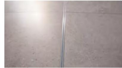
11- Respetar las juntas estructurales. Realizar las juntas de movimiento según las indicaciones del técnico de la obra. En general, no diseñar áreas superiores a 50-70 m<sup>2</sup> en interiores y la mitad en exteriores. Anchura mínima de la junta: 8 mm.
