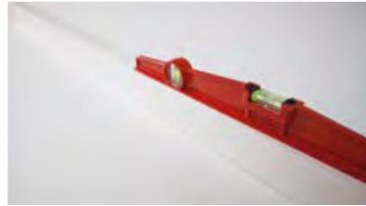
2- Comprobar que el soporte que se va a revestir sea estable y el fondo de colocación adecuado para la colocación de cerámica: superficie con textura rugosa no disgregable, perfectamente nivelada y sin defectos de planitud. Se recomienda la impermeabilización de ambientes húmedos.
